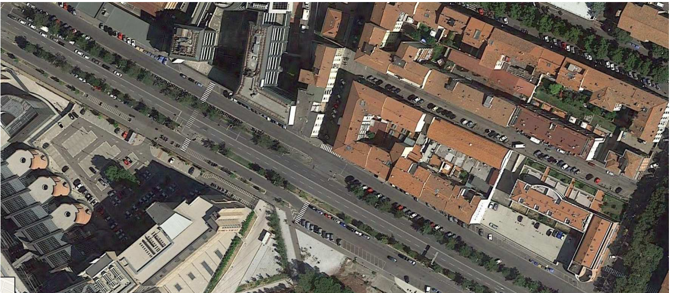
Foto aerea estratta da Google Maps Tratto da via Barsanti a via Forlanini – primo tratto
